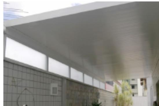
*A telha Térmica Vector, também é conhecida como telha sanduíche por ser composta de duas chapas de aço com proteção galvalume entre elas uma placa de Poliestireno Expandido (EPS), onde sua espessura pode variar conforme o projeto.*
